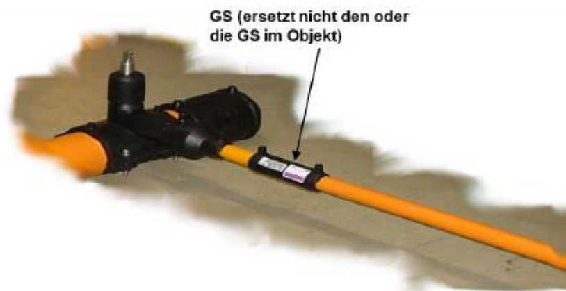
Abb. 3 Versorgungsleitung mit Netzanschlussleitung und GS
