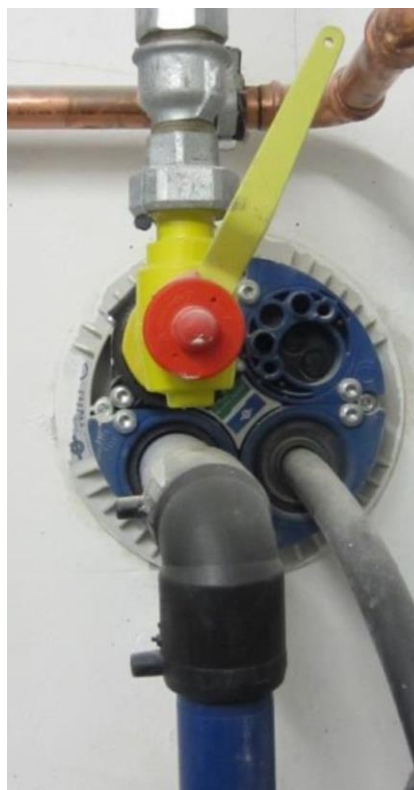
Abb. 5 Beispiel einer Mehrspartenhauseinführung
